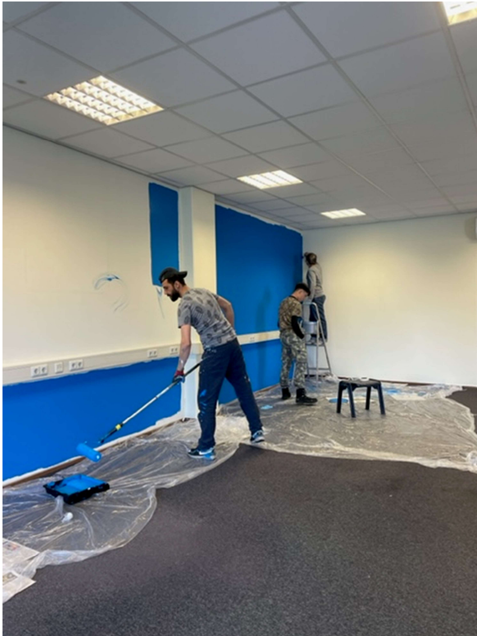
Opknappen van het nieuwe pand aan Stationsplein in 2021
